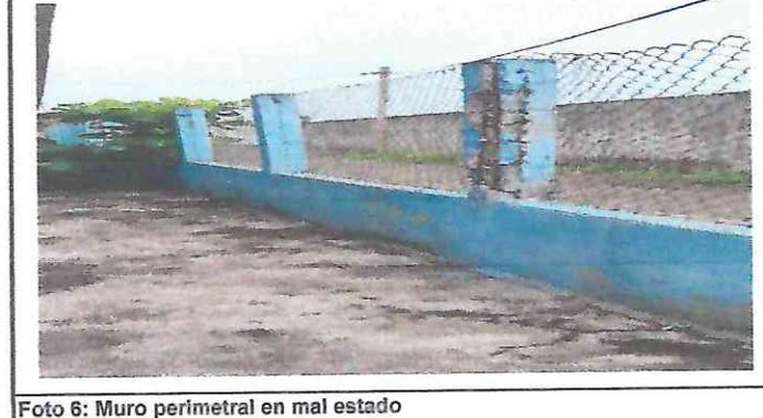
Foto 6: Muro perimetral en mal estado
